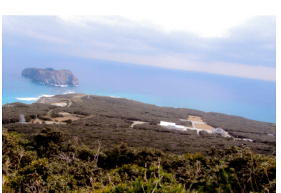
新島の南部にある試験場
